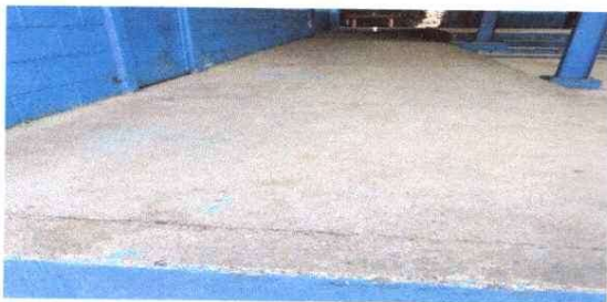
Foto 5: Sustitución de piso de torta a cerámico 274mt2 para aulas cocina y corredores.
