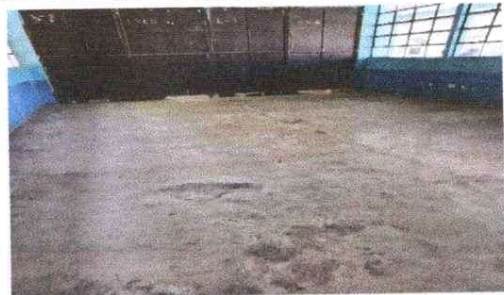
Foto 4: cambio de piso de cemento a cerámico
