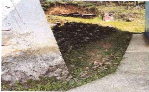
Foto 3: Muro de contención 9 x 2.90 mt2
