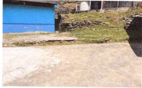
Foto 2: Ampliación de cocina 6.40 x 6 mt2
