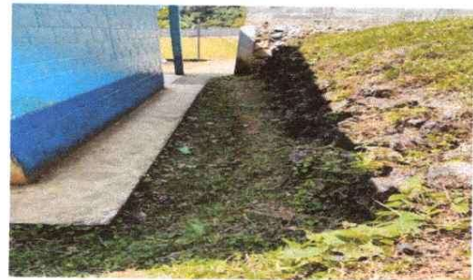
Foto 4: Muro de contención 9 x 2.90 mt2
