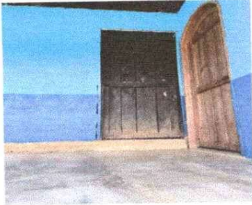
Foto1: Cambio de puertas de madera por metal
