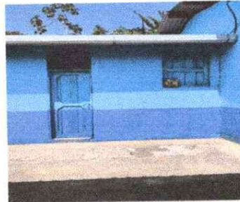
Foto 2: cambio de puertas y ventana de madera por metal
