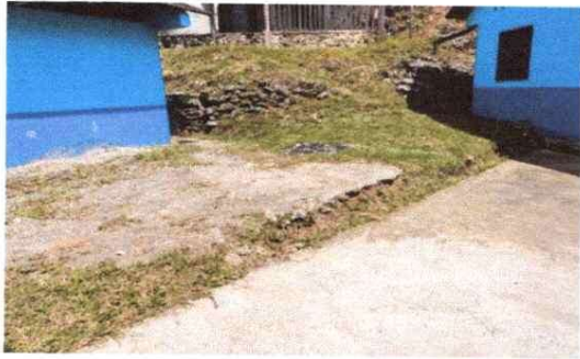
Foto 1: Ampliación de cocina 6.40 x 6 mt2
