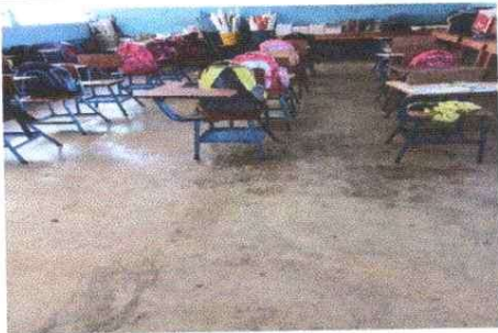
Foto 3: Cambio de piso de cemento a cerámico
